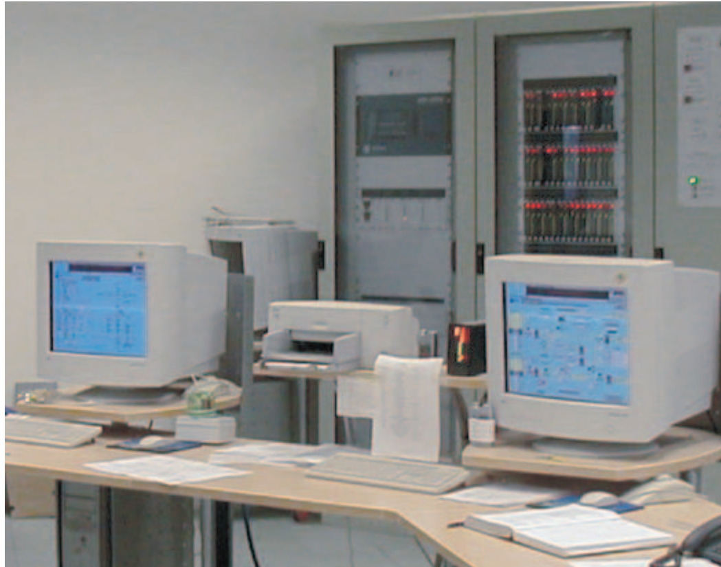
Las redes Dupline están conectadas por medio de los controladores con el Sistema de Control del Edificio
