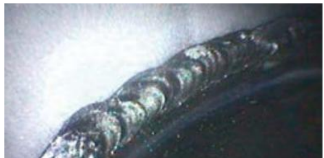
Inspección de soldadura
