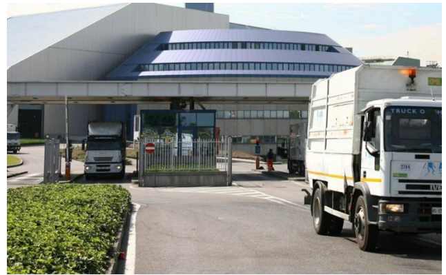
Sistema de comunicación en entrada de recinto industrial
