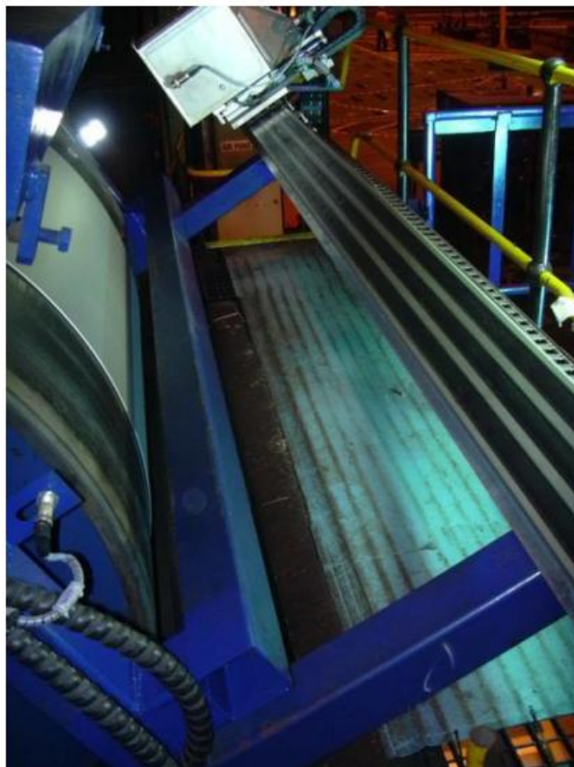
Servomecanismo y caja de inspección en línea de proceso (aproximación vertical)
