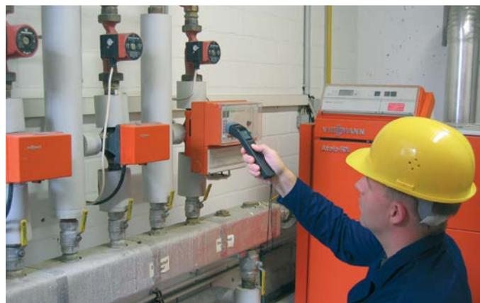
Comprobación de la temperatura en circuitos de calefacción
