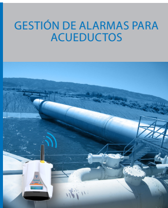
GESTIÓN DE ALARMAS PARA ACUEDUCTOS
